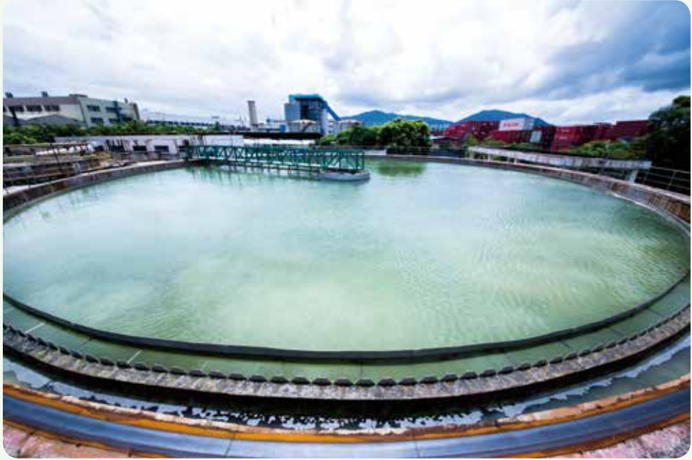
红塔仁恒废水深化项目
