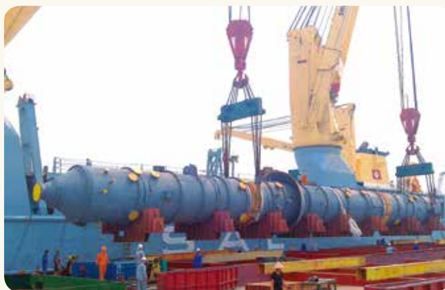
越南北氮项目大件运输现场
