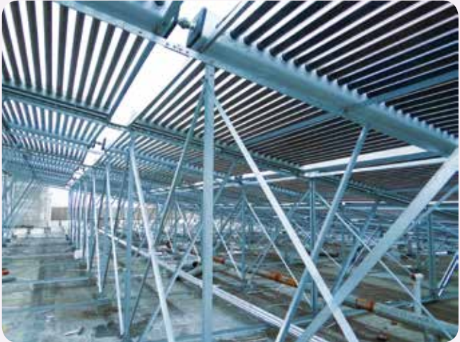
集团援建的热水器项目
