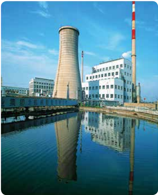
美利股份废水处理工程
