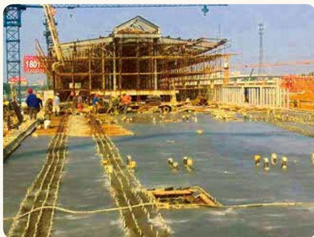
中国储运参与的南京地铁四号线工程
